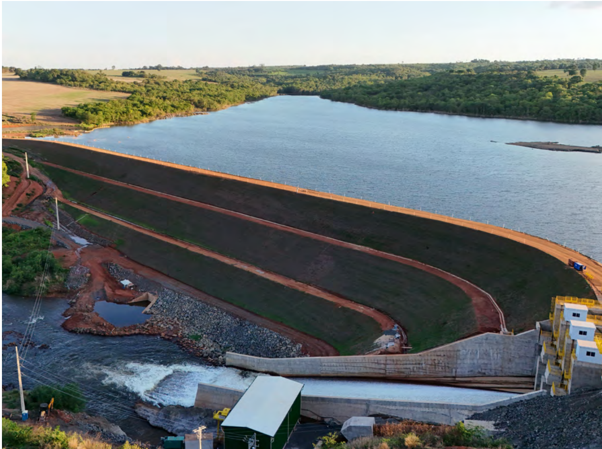
PCH (Pequena Central Hidrelétrica) Verde 2, em Rio Verde (GO)
