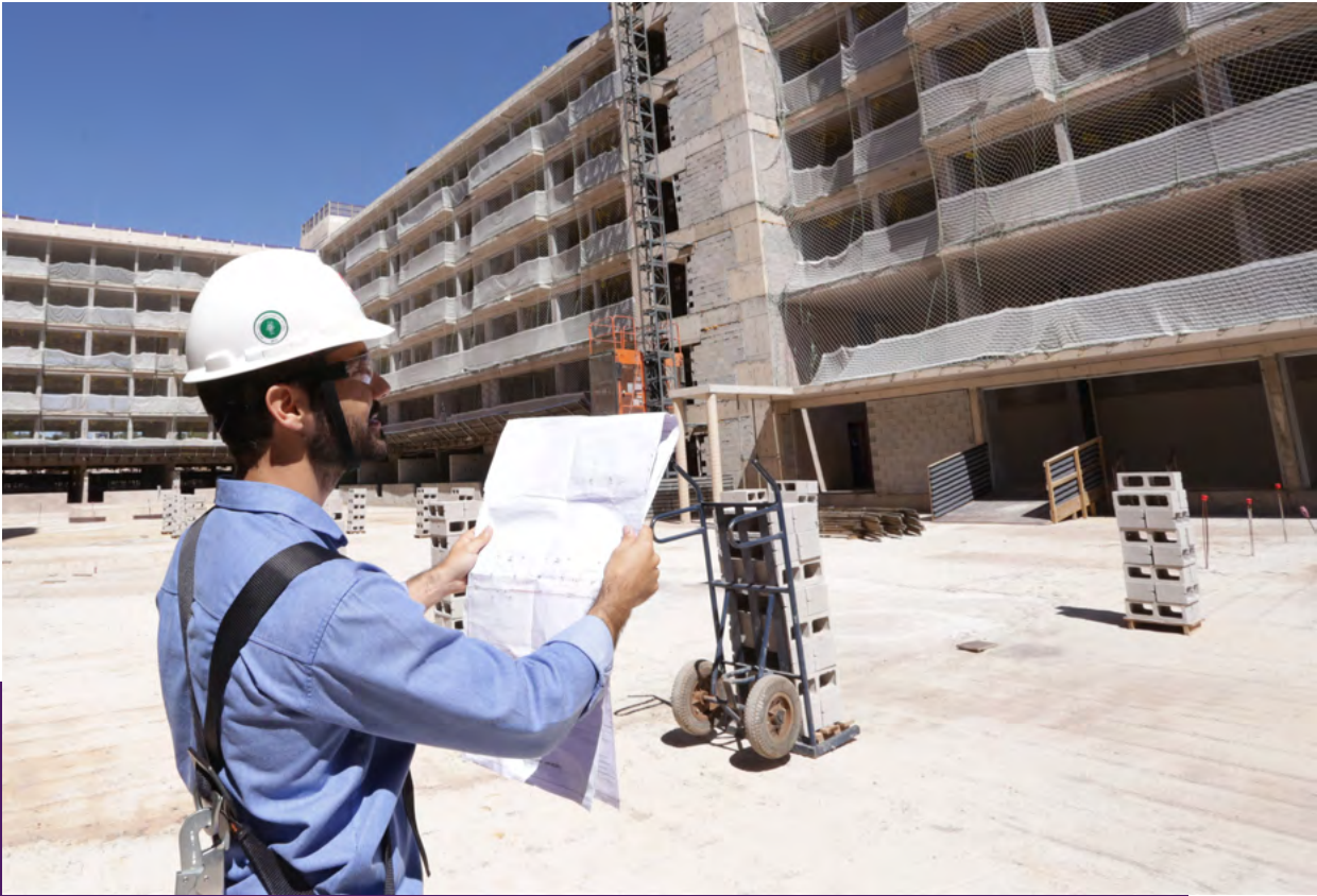
Obra do empreendimento NEXUS, no bairro Noroeste, em Brasília
